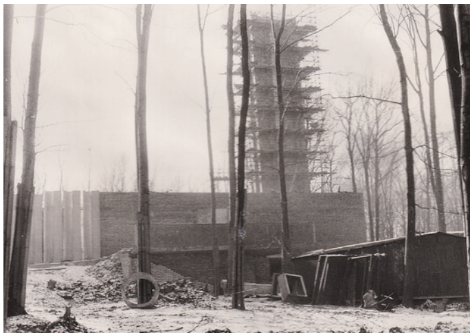
Rozestavěná budova krematoria na Lesním hřbitově. Správa krematoria a hřbitovů dříve náležela pod Technickou správu města Gottwaldova. Koncepce rozvoje Technické správy města Gottwaldova do roku 2000, osobní archiv Ing. Františka Kostelníka.
