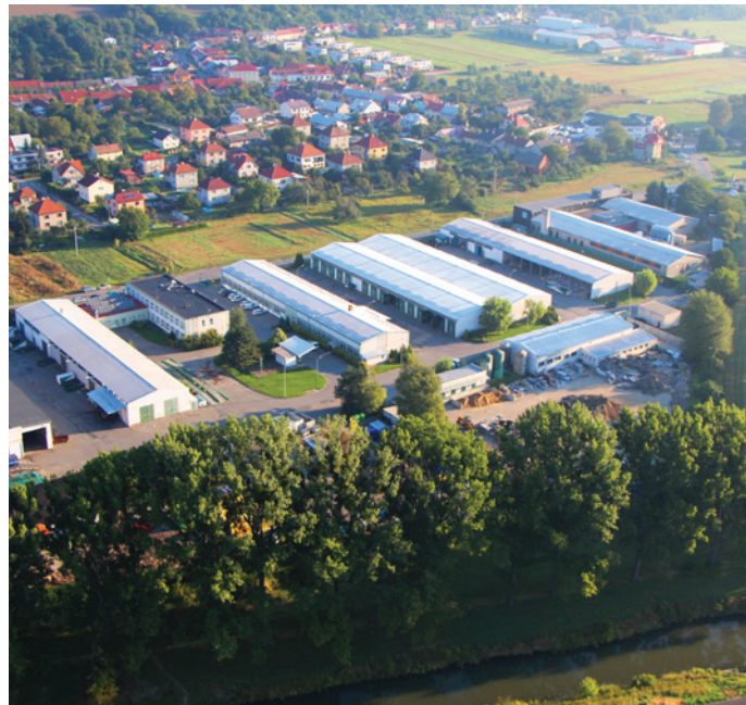
Letecký pohled na areál Technických služeb Zlín, v pozadí zástavba čtvrti Louky. Archiv TS Zlín.
